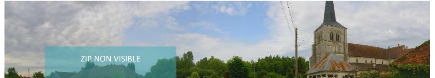
Figure 105 : L'Eglise Saint-Pierre à Pouan-les-Vallées (03/06/2019)
